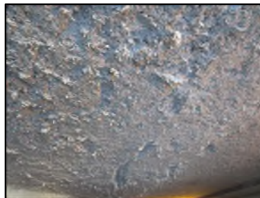
Photo N° 663 ECH-N°1 FLOCAGE -- LOCAL POUBELLE Plafonds Blanc cotonneux
